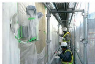
作業 3 D-47 塗装(2回塗り)
