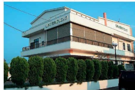
3. クリニック屋根・外壁 (愛媛)
