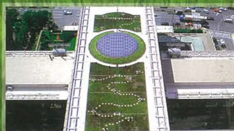
[防水層の熱劣化対策] 都市ホテル屋上
