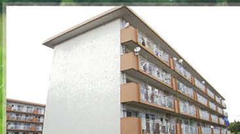
[優れた耐汚性能] 施工後9年経っても色あせない集合住宅の外壁面
